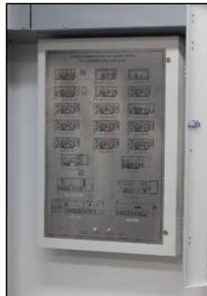
ภาพที่ 76 Fire Alarm Control Panel
