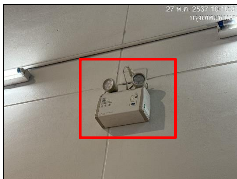
ภาพที่ 31 ระบบไฟฟ้าฉุกเฉิน
